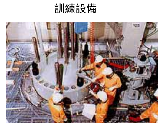
原子炉容器上ぶたの スタッドボルト締付(訓練)
