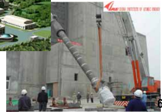
原子炉建屋に移動中の蒸発器(2005年3月)
