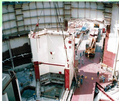
SC(鋼板コンクリート) 内部構造
