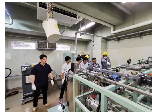
ポンプ実習の様子
