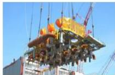
ABWRの高圧ドレンポンプ 配管・弁室モジュール
