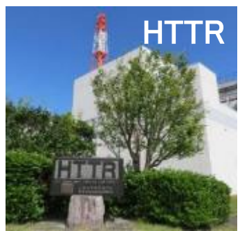
HTTR (高温工学試験研究炉)
