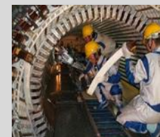
発電機補修工事
